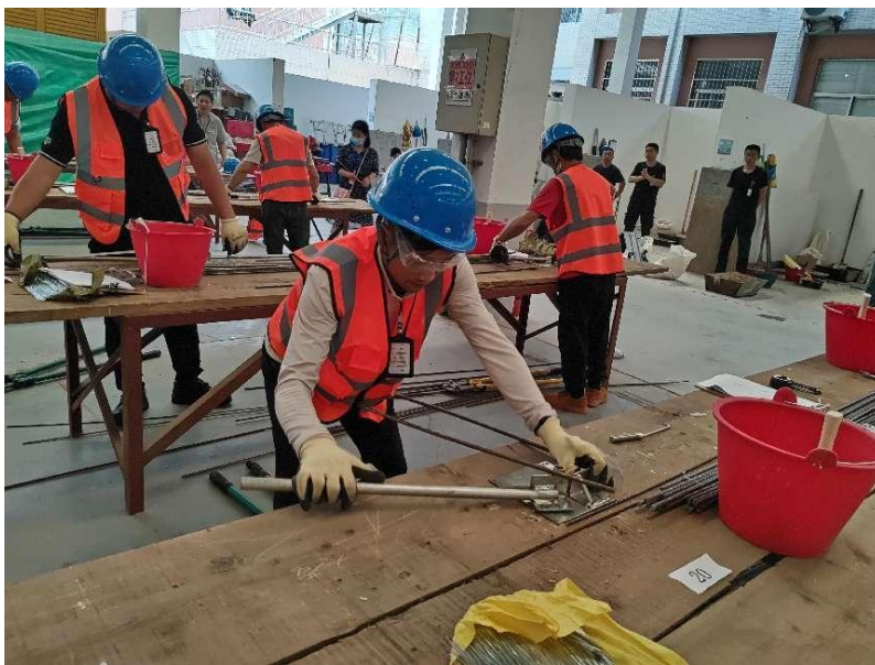
图 4-1. 开展钢筋工技能考核
